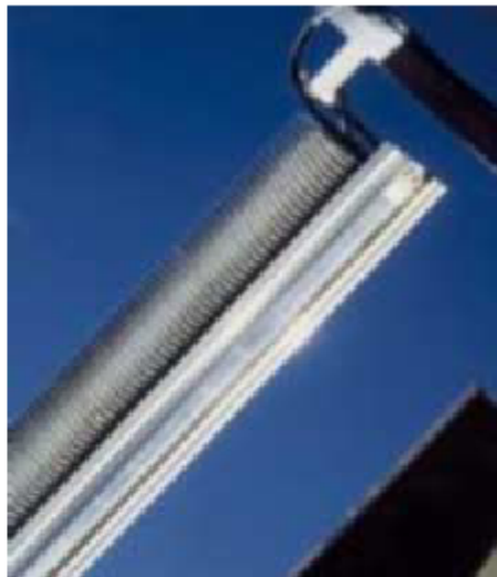
Figur 2: Närbild av de luftkylda solcellerna i det koncentrerande systemet i Rockingham.
